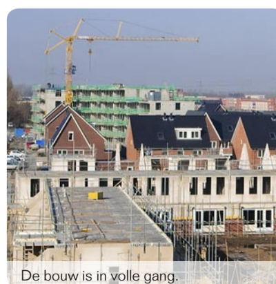
De bouw is in volle gang.
